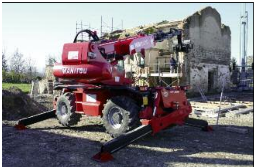
■ L'utilizzo dell'MRT 2150 con una benna miscelatrice ha permesso l'esecuzione di getti in calcestruzzo senza coinvolgere l'impiego di una betoniera e mantenendo la massima pulizia dell'area interessata dai lavori
